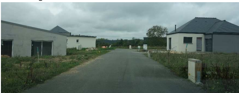
Zone 1AU1 du Champ Piry en cours d'urbanisation
